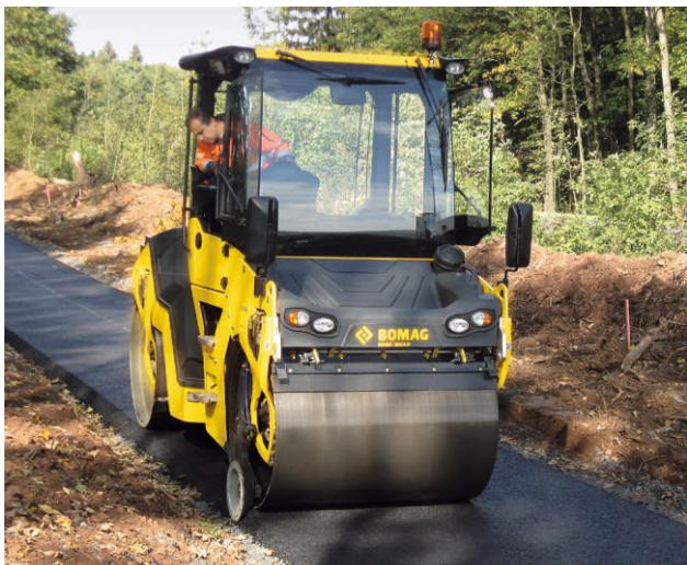
Благодаря своим компактным размерам BOMAG BW 141 AD имеет преимущества при строительстве подъездных дорог.
